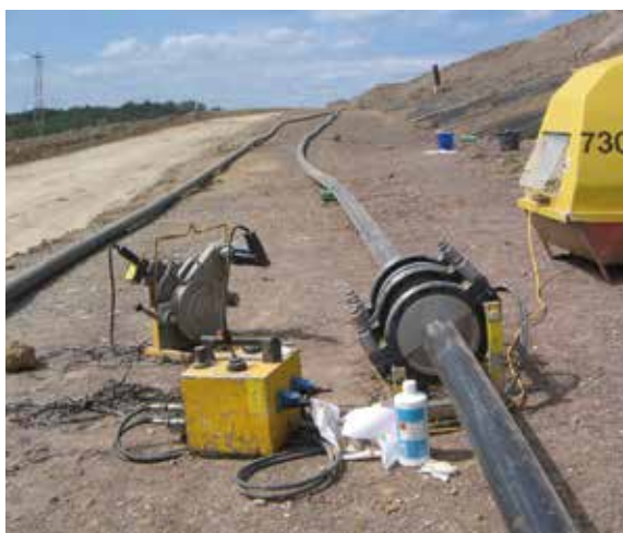
Anschluss Sickerwasserschacht Connection leachate duct
