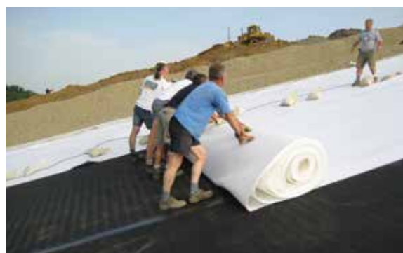
Einbau der Ausgleichs- und Entgasungsschicht Assembly of levelling and degasification layer
