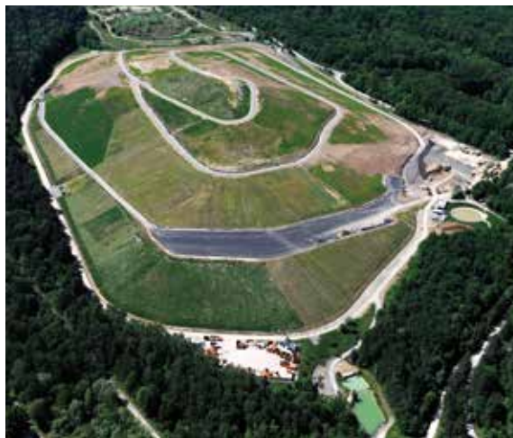
Bauzustand aus Süd-Ost im Jahr 2008 Status of construction from south-east in 2008
